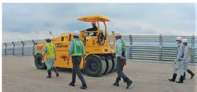
写真-1 プルーフローリング試験（従来方法）
