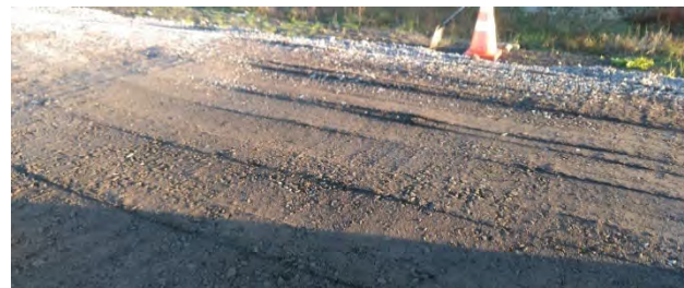
写真-2 塑性変形の例
