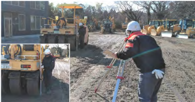
写真- 6 レベル測量による変形量の計測
