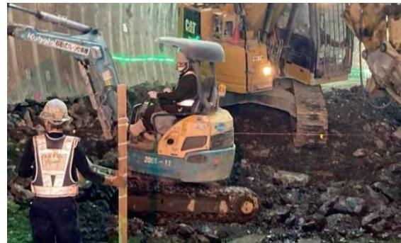
写真-1 インバート掘削状況
