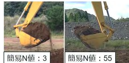
図-9 掘削終了後のバケットの荷姿（粘性土）
