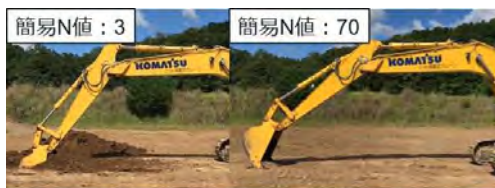
図-15 刃先停止時のバケットの貫入状況の比較
