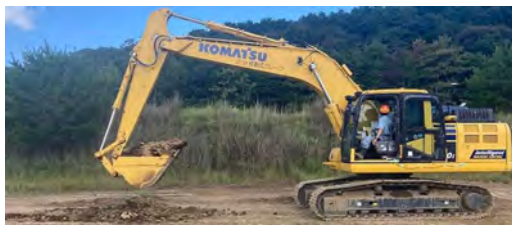
図-4 掘削終了後の一例
