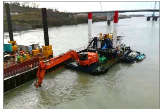
写真-2 バックホウ浚渫船の掘削状況
