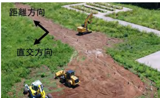
図-5 検証現場の様子
