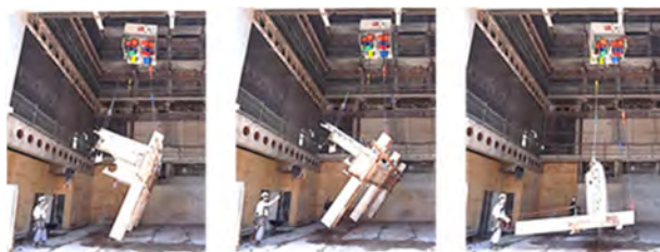
写真-5 吊荷反転
