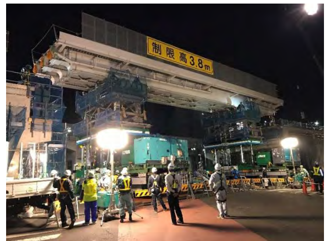
写真-5 送出し工状況
