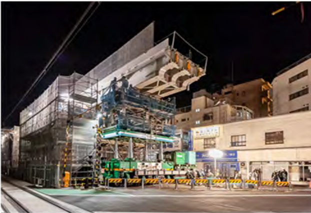
写真-1 施工状況
