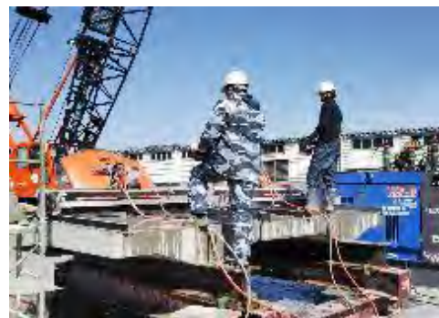
写真-1 スタッドジベル切断の様子
