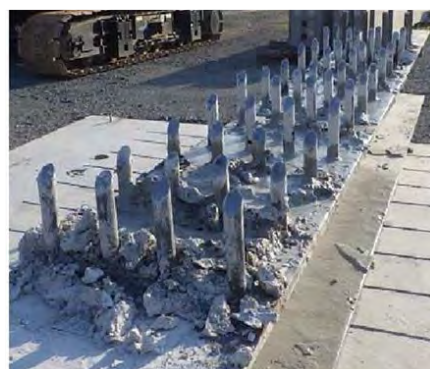
写真-3 実験後の鋼桁上のスタッドジベル (1)
