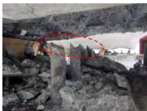
写真-4 実験後の鋼桁上のスタッドジベル (2)
