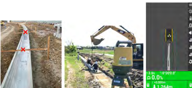
写真-3 3次元設計データを活用した構造物設置
