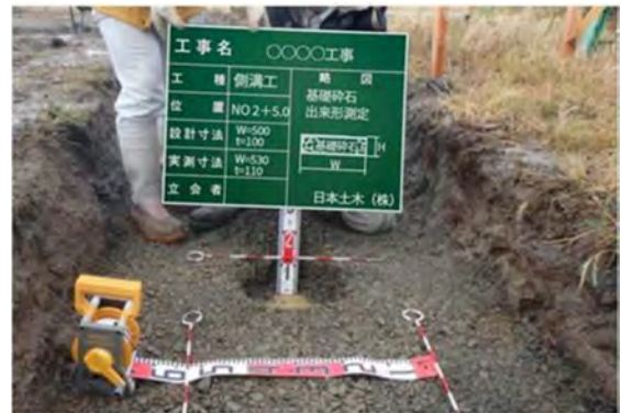
写真-5 従来の出来形計測(床堀)
