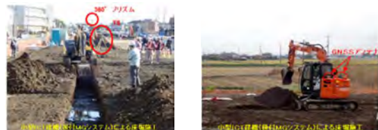
写真-1 小型ICT建設機械による施工状況
