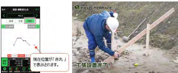
写真-2 3次元設計データを活用した丁張設置
