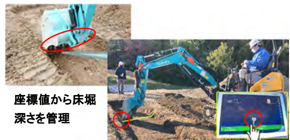
写真-6 刃先データを活用した出来形計測(床堀)
