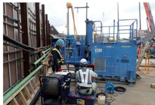
図-5 削孔精度計測状況
