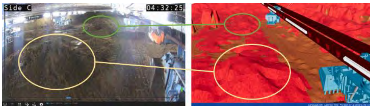
図-7 現場環境における地盤計測(左)と 3D 可視化画面(右)
