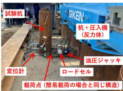
図-9 通常載荷試験（水平）の実施状況
