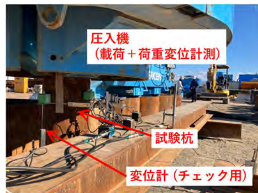
図-3 簡易载荷試験（鉛直）の実施状況
