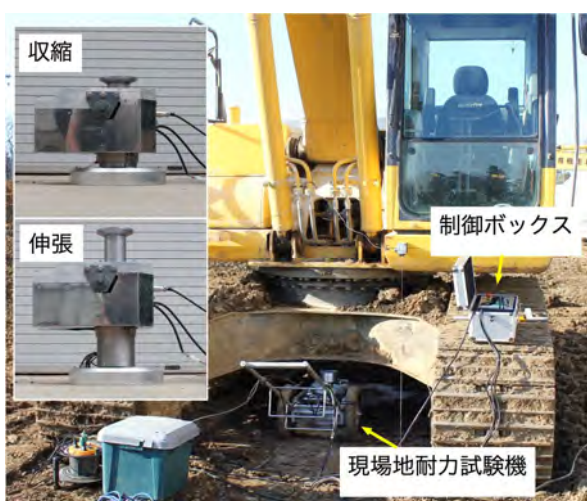
図-3 現場地耐力試験 (BCT) の概要
