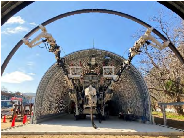
図-9.2 模擬トンネル内での試験状況
