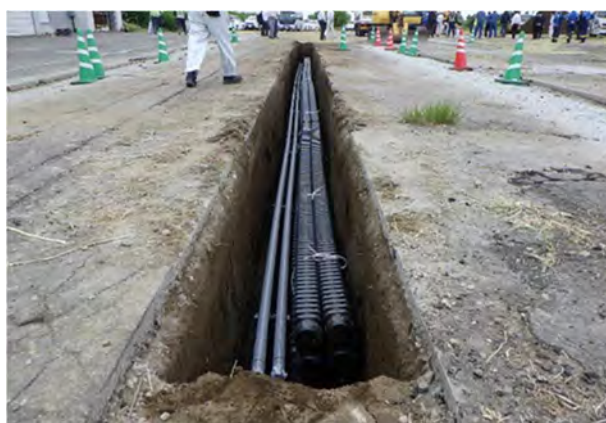
写真-5 敷設状況
