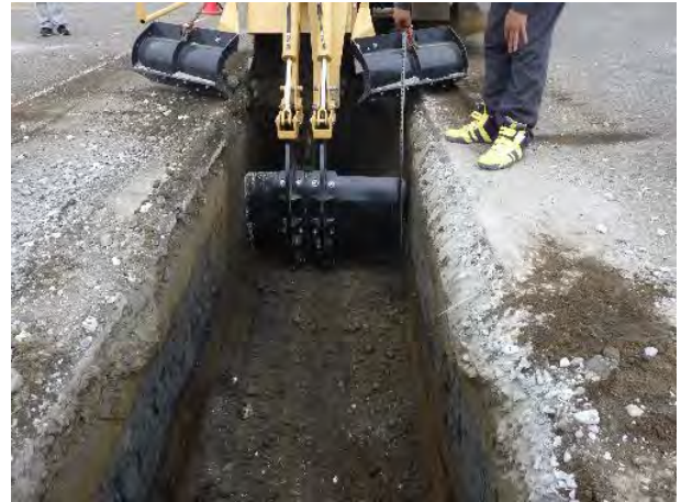
写真-8 掘削状況
