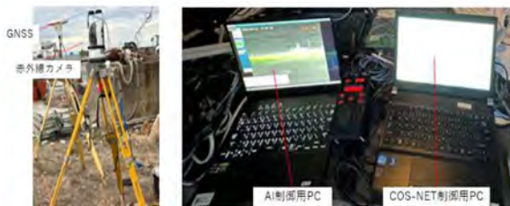
写真-4 機材設置状況
