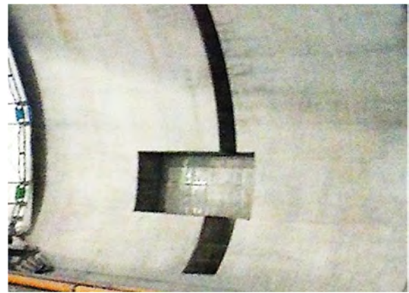
写真-8 箱抜き箇所の充填状態
