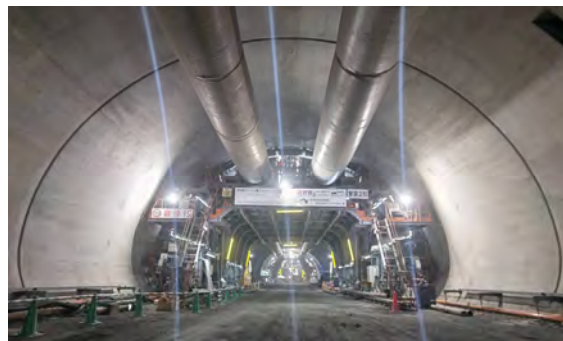
写真-7 高流動覆工コンクリートの仕上がり
