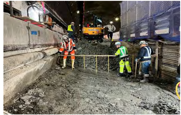
写真-4 通常の状態管理状況
