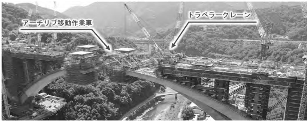
写真-5 移動作業車とトラベラークレーンの位置関係
