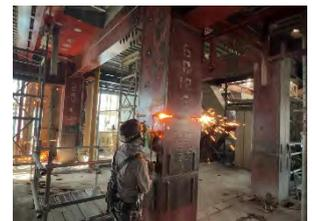
図-4 柱のガス切断
