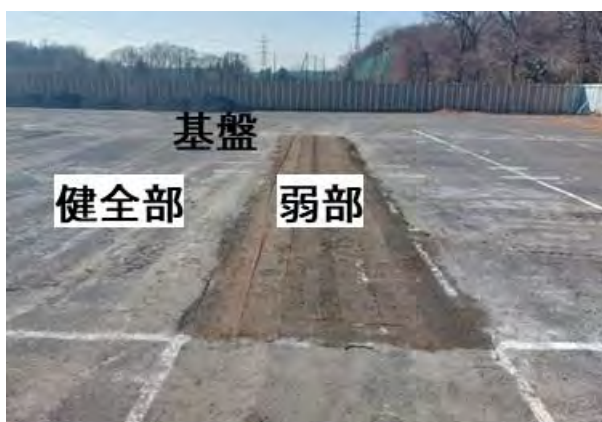
写真-1 基盤への弱部設置状況
