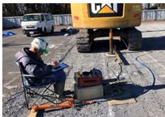
写真-5 平板載荷試験
