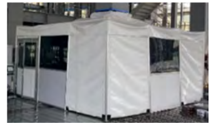
写真-11 システム養生
