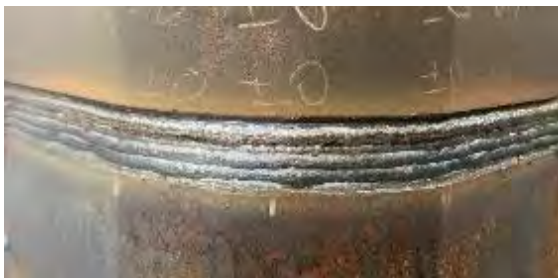
写真-10 スラグ除去後外観
