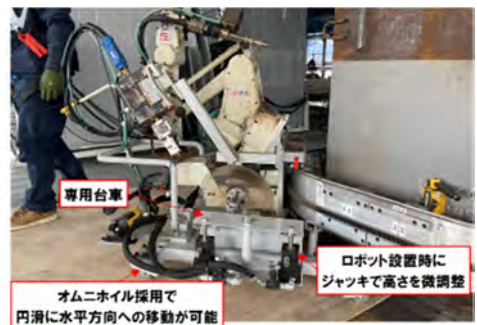
写真-12 盛替え状況
