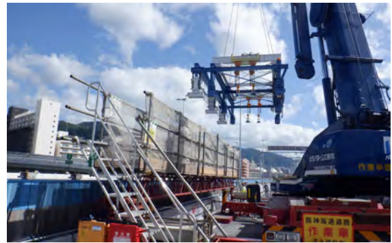
写真-6 床版架設機投入状況
