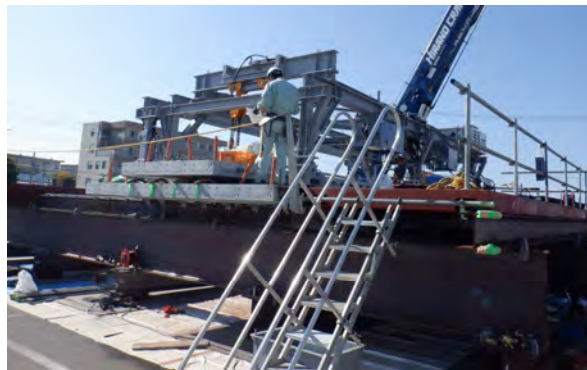
写真-3 実物大施工性確認試験
