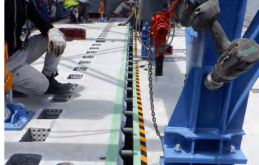
写真-2 PS 接合床版の接合作業状況
