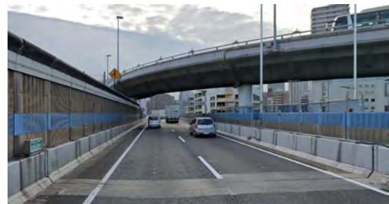
写真-1 工事対象橋梁京橋方状況
