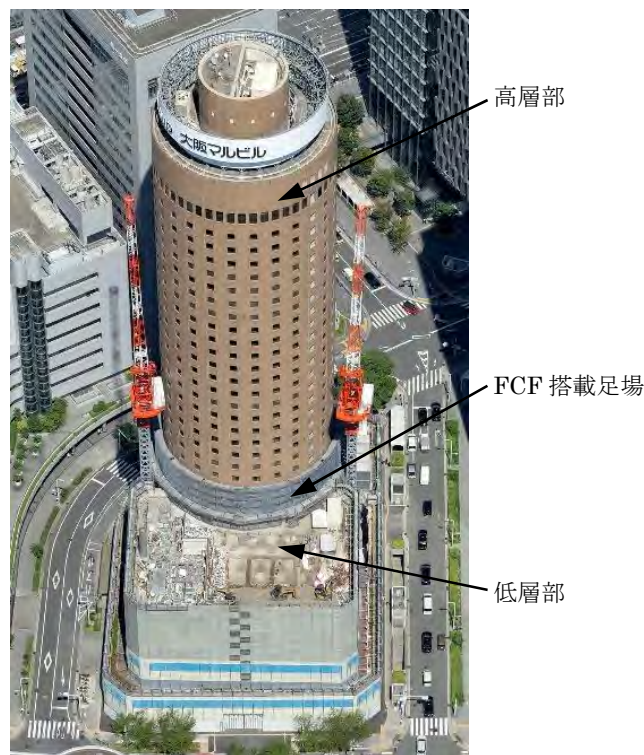
写真－6 施工建物
