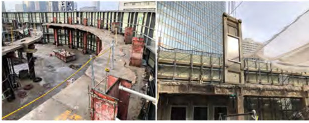
写真－１０ 躯体解体状況
