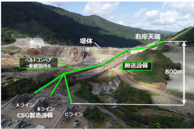
写真-1 材料搬送設備配置：製造設備から右岸天端へ
