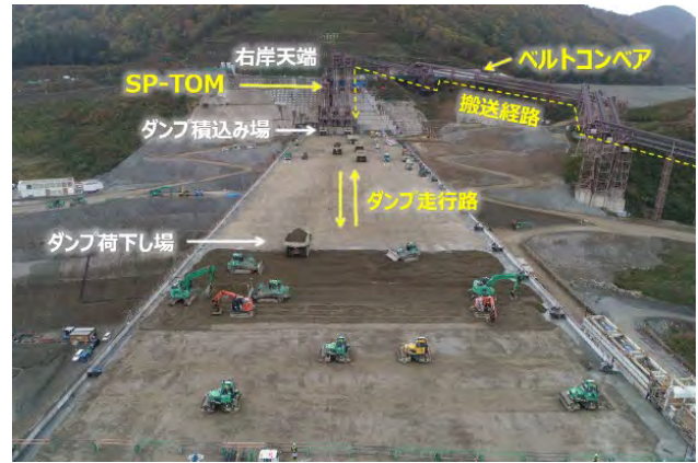
写真-3 堤体全景と材料搬送設備
