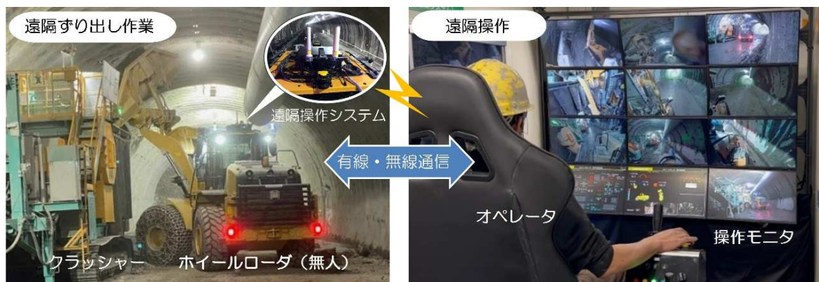
写真-1 遠隔ホイールローダによるずり出し状況
