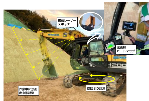
写真-1 重機搭載レーザー計測システム
