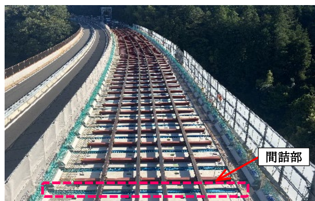
写真-4 走行レール敷設状況
