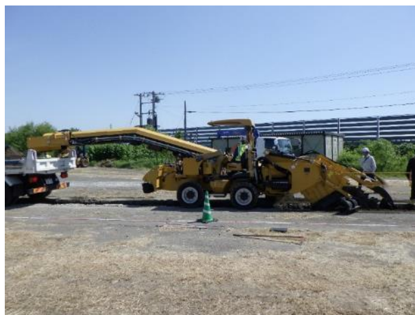
写真-1 トレンチャー試験施工状況
