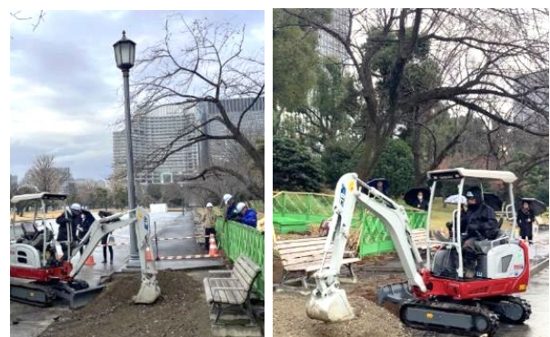
(b) 歩道のベンチ再設置に向けた掘削土の埋戻作業
