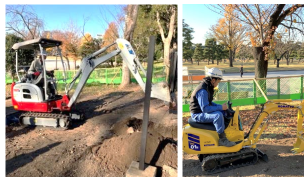
(a) 防護柵の設置に向けた掘削・整地作業
