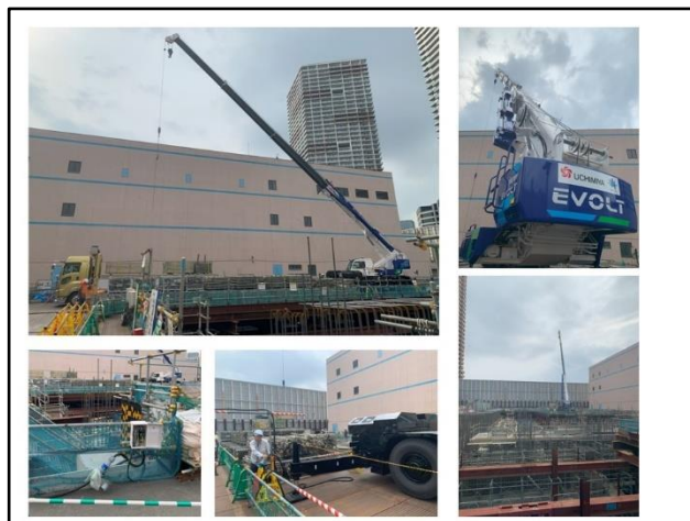
図-2 電動ラフテレーンクレーン稼働例
