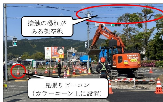
写真-7 交差点アスファルト剥ぎ取り
