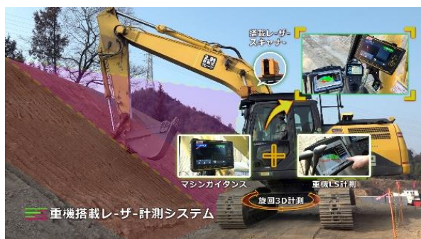
図-2 STEP1 施工しながら出来形管理
