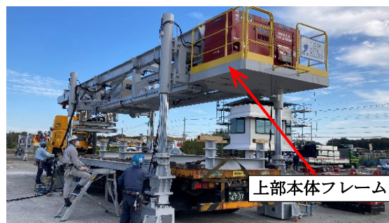
写真-9 上部本体フレーム組立状況
