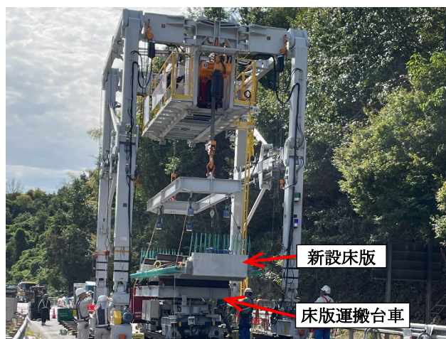
写真-7 新設床版積み替え状況
