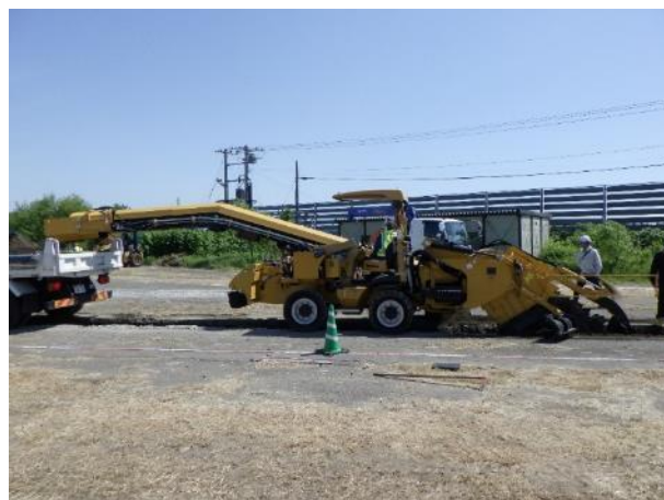
写真-1 トレンチャー試験施工状況
