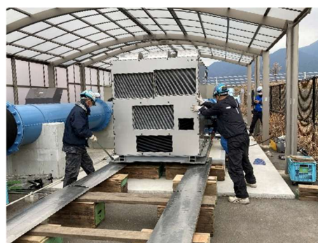
写真-1 エンジン交換作業の状況（福智町）
