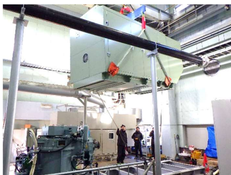
写真-3 エンジンBの搬入状況
