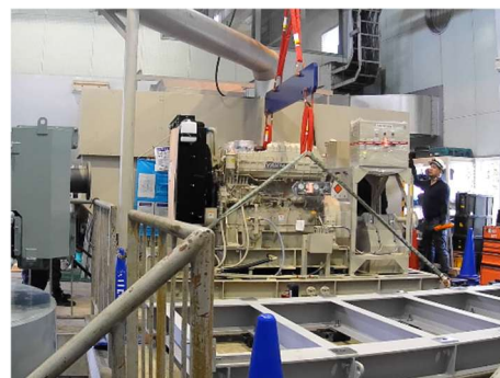
写真-4 エンジンAの搬出状況
