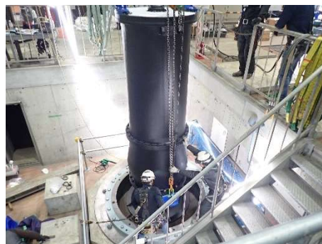
写真-2 主ポンプの据付状況
