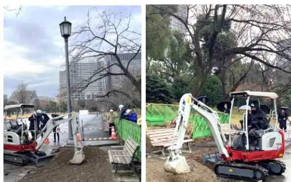
(b) 歩道のベンチ再設置に向けた掘削土の埋戻作業
