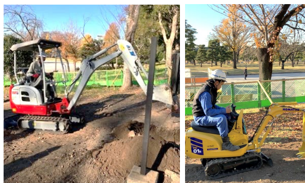
(a) 防護柵の設置に向けた掘削・整地作業
