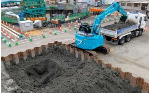
写真-12 自動運転での積込み状況
