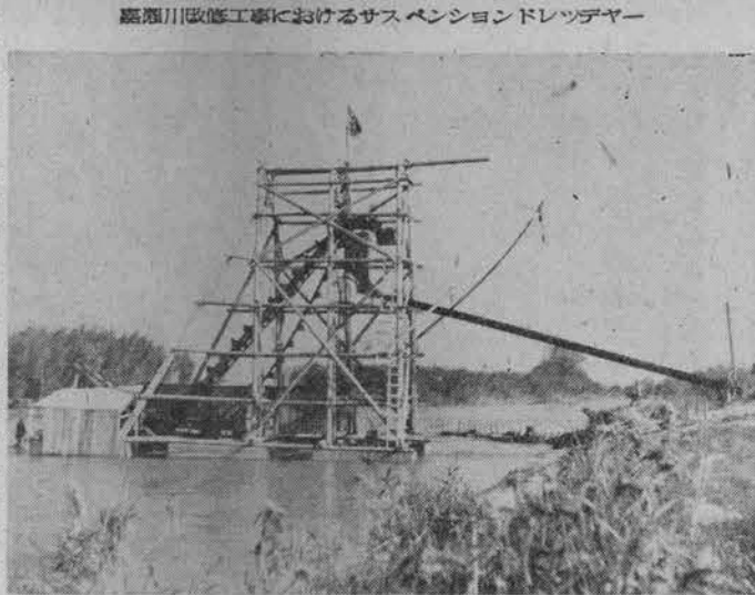
嘉瀬川改修工事におけるサスペンションドレッツチャー
