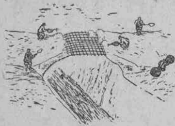
第三図 構築中の雪氷橋
