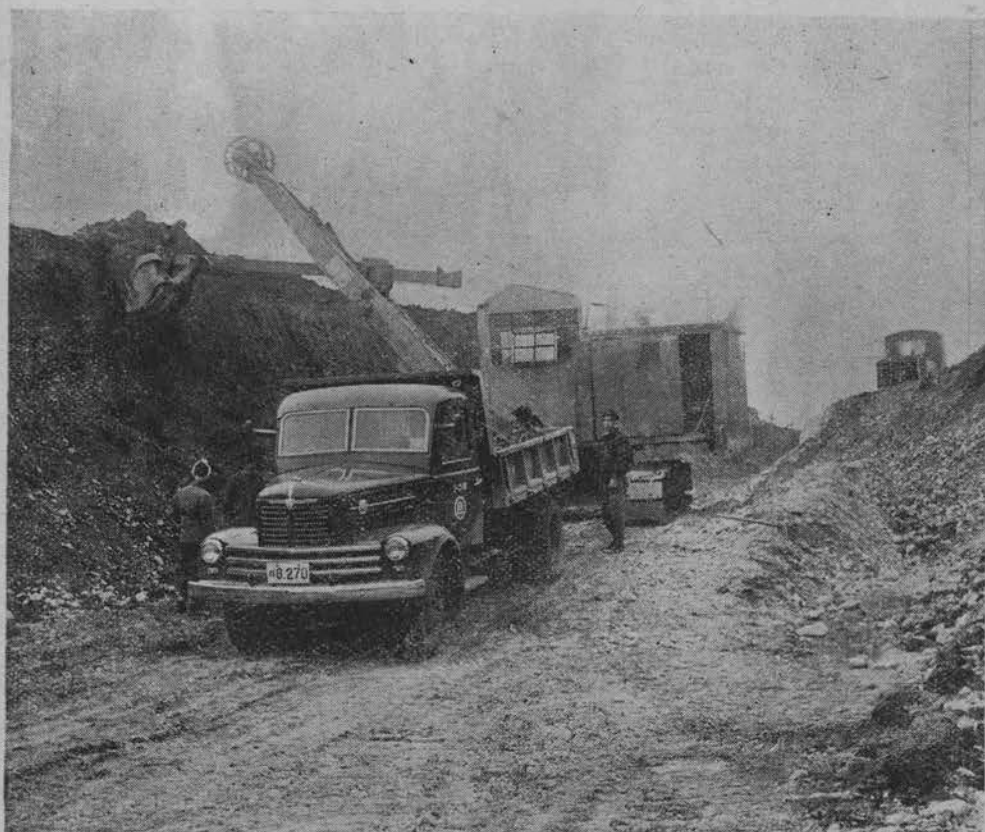
見返り資金による東海道改良工事現場の作業状況
