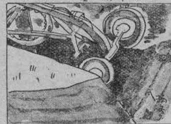
第二圖 掘鑿作業中
