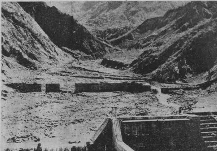
白岩堰堤より松尾堰堤を望む
