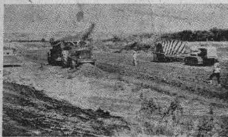
3 図 満載した底開きダンプワゴンからの土をブルドーザーでならし大型スパイクローラーで締めめる
