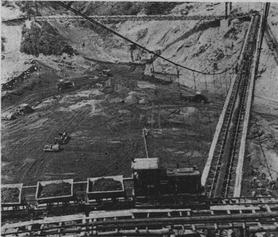
農林省羽鳥アースダム築造現場
