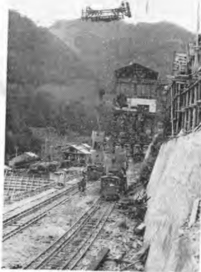
(ケーブルクレーン) コンクリート混合工場及びコンクリート輸送設備
