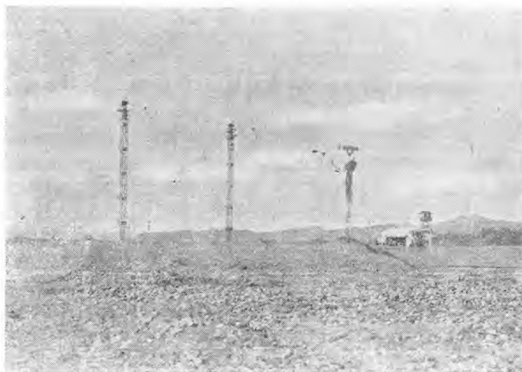
第 4 図 固定型 2m 3 タワーエクスカベータ (北上川)
