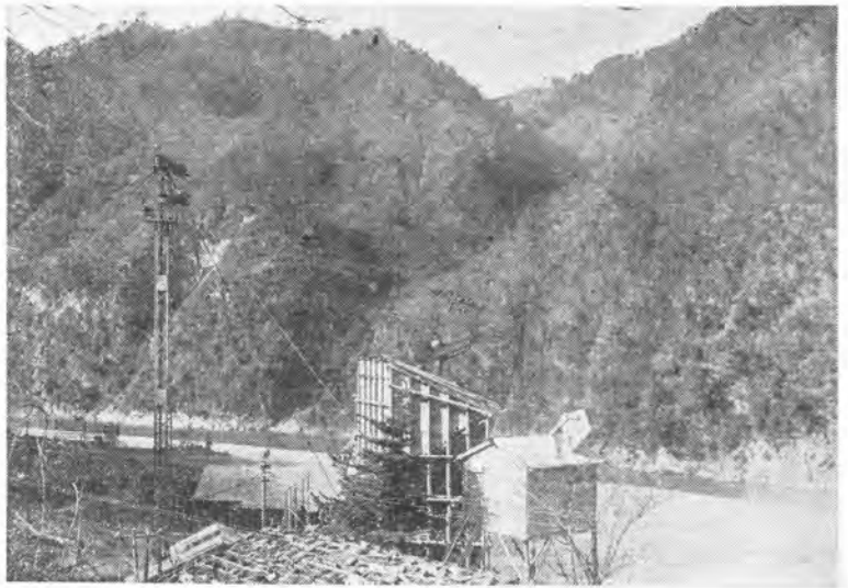
(左) 第 5 図 走行型 1.2 m 3 タワーエクスキャベータ (九頭竜川)
