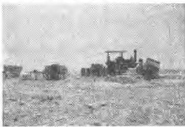
新設道路にロードローラをかけているところ
