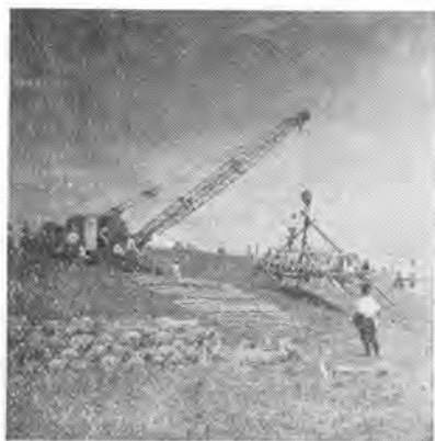
川倉を吊っているところ。法面にあるのは設置を終った簀の子。洪水時には手前を水が流れている。
