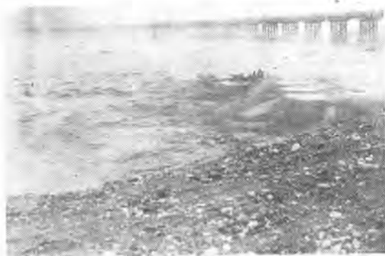
7月1日大日橋附近出水状況
