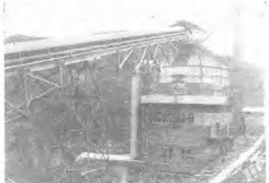
丸山ダム工事現場
