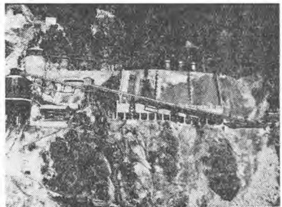
写真-1 仮設備工事 骨材貯蔵所ベルトコンベヤ、パッチャープラント
