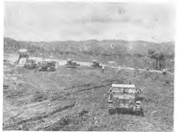
堤体下流側盛土輾圧
