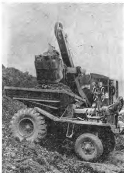
第5図 ラストンビサイラス会社の12碼パワーショベルとエプリングパーフォード会社の4 \frac{1}{2} 碼のダンパ
