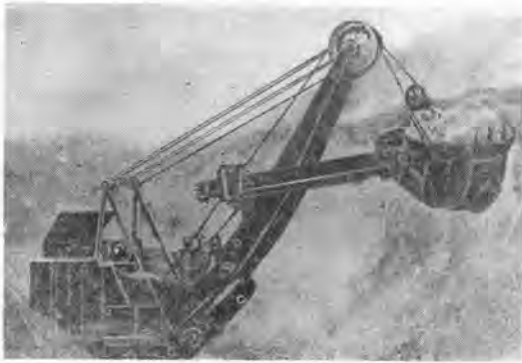
図-10 煉瓦工場現地における本エクスカバートル
