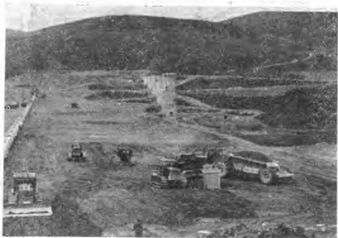
第8図 土壌掘削中のブルドーザとホットムダンプ
