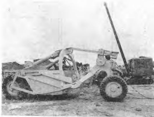
第9図 ジャックオルディング会社の8噸スクレーパー
