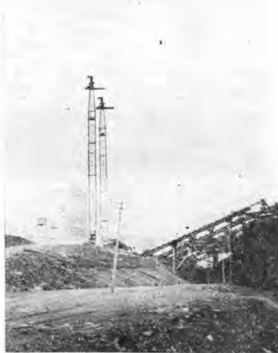
第6図 ヘンダーソン会社のケーブルクレーン
