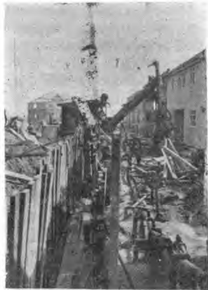
第4図 プリストマン会社の3/8碼ドラグショベルとウエルポイントの配管
