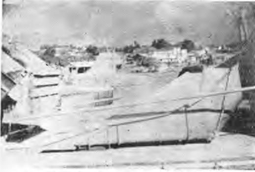
写真-2 ダンプトラックからベイパのホッパにバッチを降したところ
