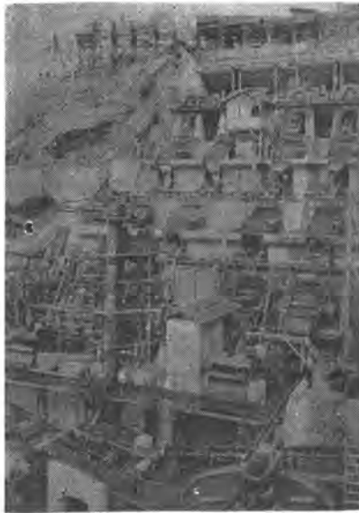
丸山ダム骨材破碎篩分装置
